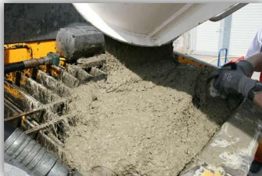
**B STRATOS RS** est une fibre en polypropylène, de haute technologie, pour le béton projeté par voie humide et sèche.
